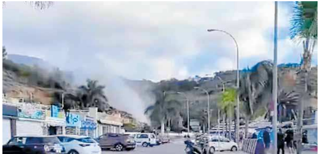
Die durch den Rohrbruch verursachte Wassersäule an der Promenade am Burriana-Strand. sur
