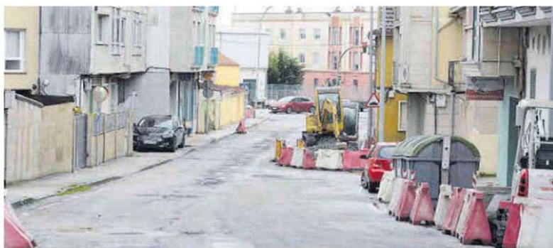
Obras de la primera fase, cuya tardanza provocaron las protestas vecinales. | Gonzalo Núñez
